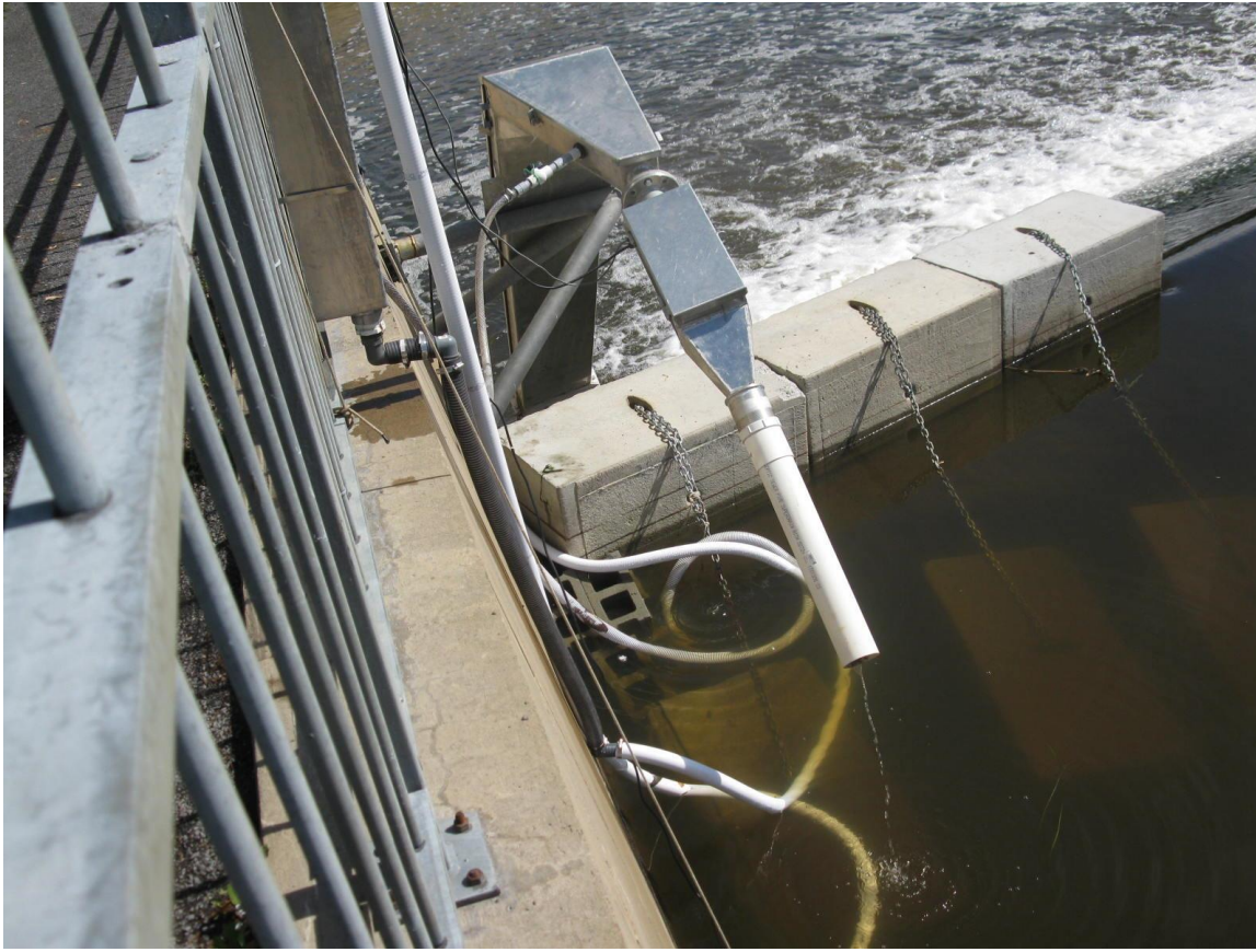
Photo de l'exutoire de la passe migratoire à anguille à L'Épiphanie dans la région de Lanaudière illustrant l'aménagement des blocs de béton. (Source : C. Côté, MFFP, 2017)
