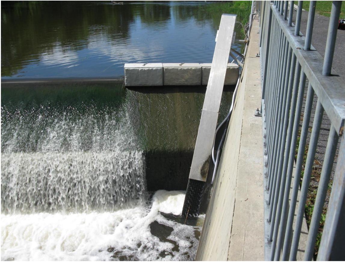
Photo de la passe à anguille de l'Épiphanie dans la région de Lanaudière. Des blocs de béton ont dû être installés pour faciliter l'accès aux anguilles vers la passe migratoire (Source, C. Côté, MFFP. 2017)
