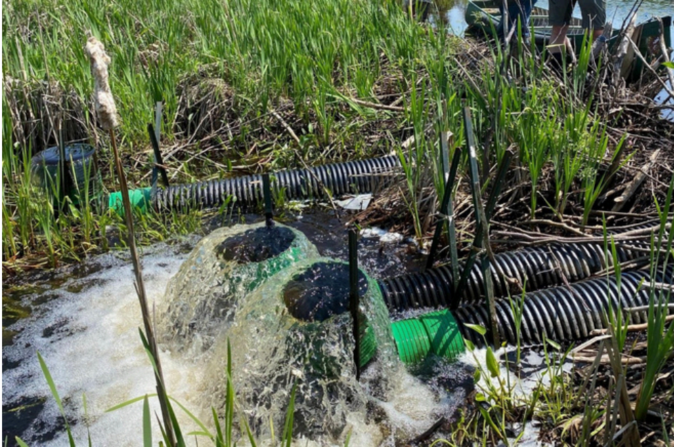
FIGURE 1.16 : Exemple de drains activés
