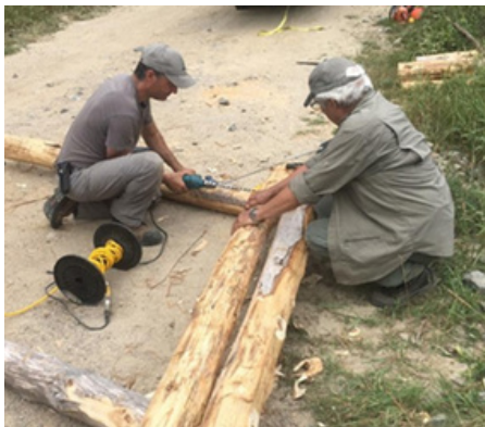
FIGURE 1.1 : Assemblage du flotteur
