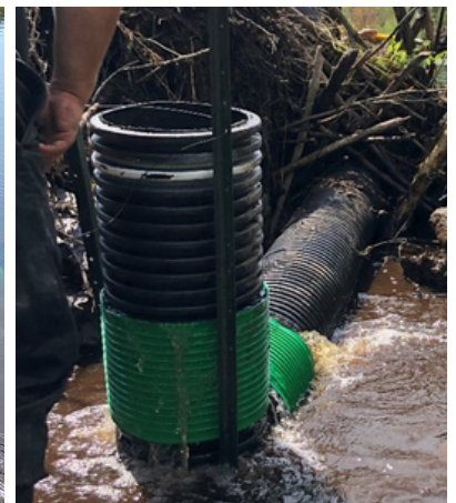
FIGURE 1.15 : Fixation du drain vertical
