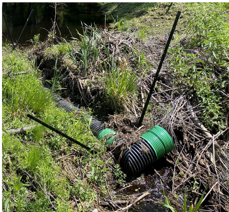
FIGURE 1.9 : Creusage de la brèche de l'aval vers l'amont
