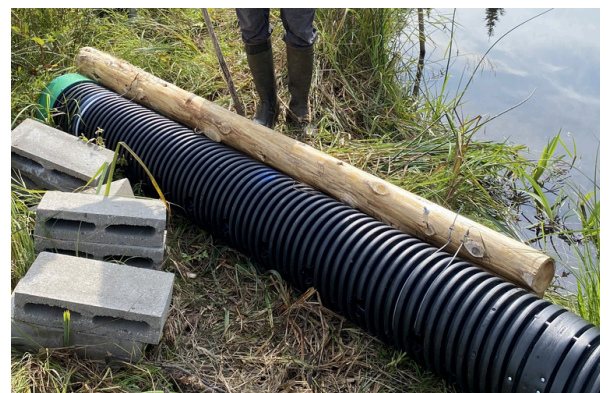
FIGURE 1.3 : Fixation de la prise d'eau au flotteur
