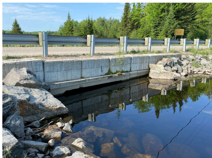
FIGURE 6. Rehaussement du niveau d'eau près d'une route traversant un cours d'eau
