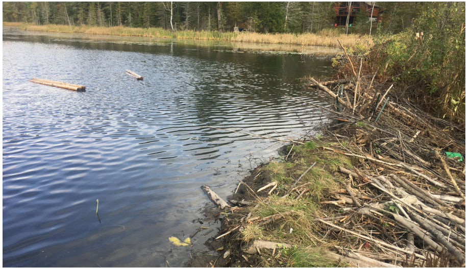
FIGURE 9. Exemple de la prise d'eau sous le flotteur Leclair à plus de 7 m du barrage. Crédit : JNF Inc.
