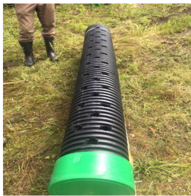
FIGURE 1.2 : Aperçu de la prise d'eau avant assemblage
