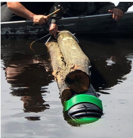
FIGURE 1.13 : Fixation des ancrages sur le flotteur
