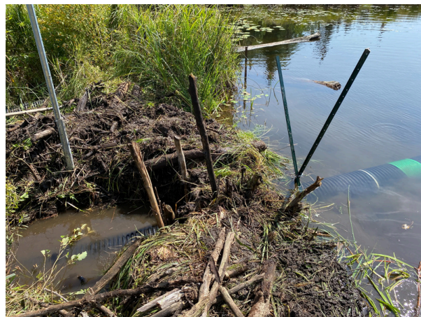
FIGURE 1.14 : Fixation du drain solide et colmatage de la brèche
