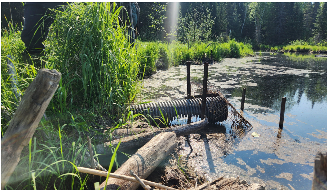
FIGURE 8. Cube Morency rongé par la corrosion
