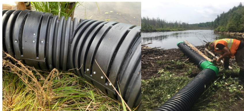
FIGURE 1.4 : Coude 45° fixé à la prise d'eau (2 types de raccords)
