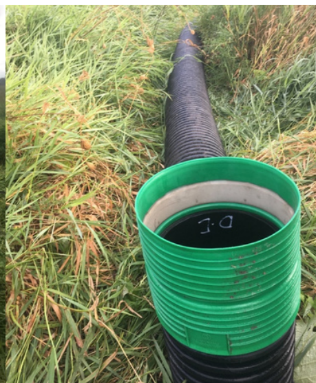
FIGURE 1. 7 : Positionnement du coude 90° avec raccord de silicone
